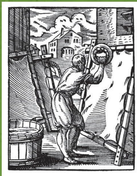
Vyčištěná kůže při výrobě pergamenu se napínala na rám, kde se nechala vysušit
