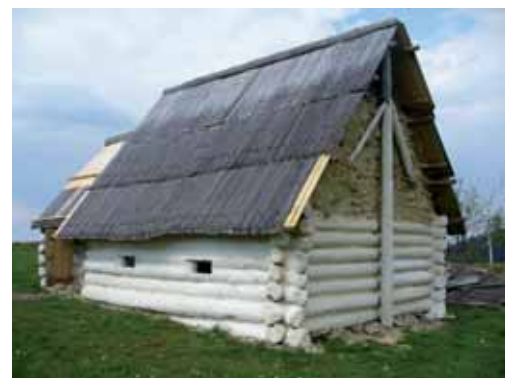
Obydlí šafáře – správce dvorce – na opevněné akropoli (Curia Vítkov)
